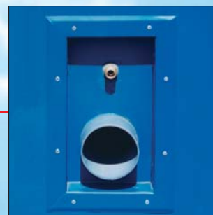
Água canalizada incorporada na parede
